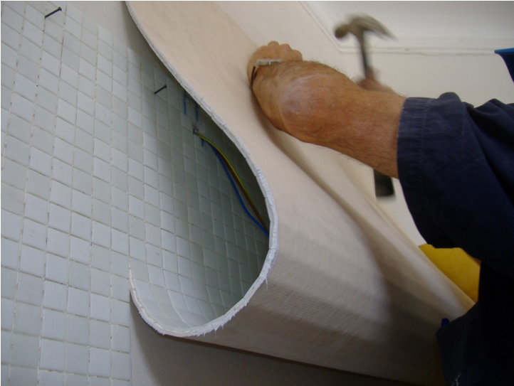
De flexibele opbouw van het mozaïekbehang van PRONTO MOZAÏEK.
